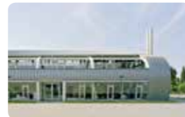
Rational Landsberg, Neubau Werk 3
