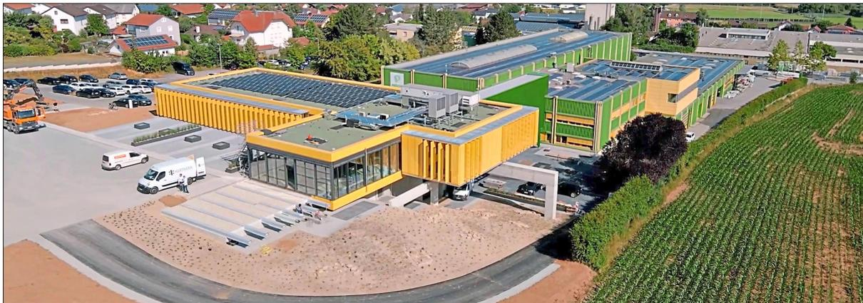
**Der Erweiterungsbau** (gelb, im Vordergrund) fügt sich in den Hang des Firmenareals in Arnstorf ein und ist mit einer Stahlkonstruktion mit dem Hauptgebäude (grün, im Hintergrund) verbunden. – Foto: Pröckl GmbH
